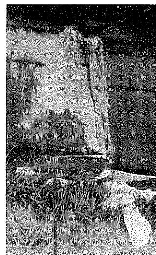
写真は側溝の水路の壁の線でも分かる地震による断層(零石町内)
